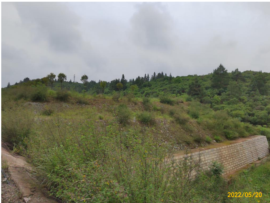
图8 道路工程区 K21+350 道路右侧挡土墙防治效果
