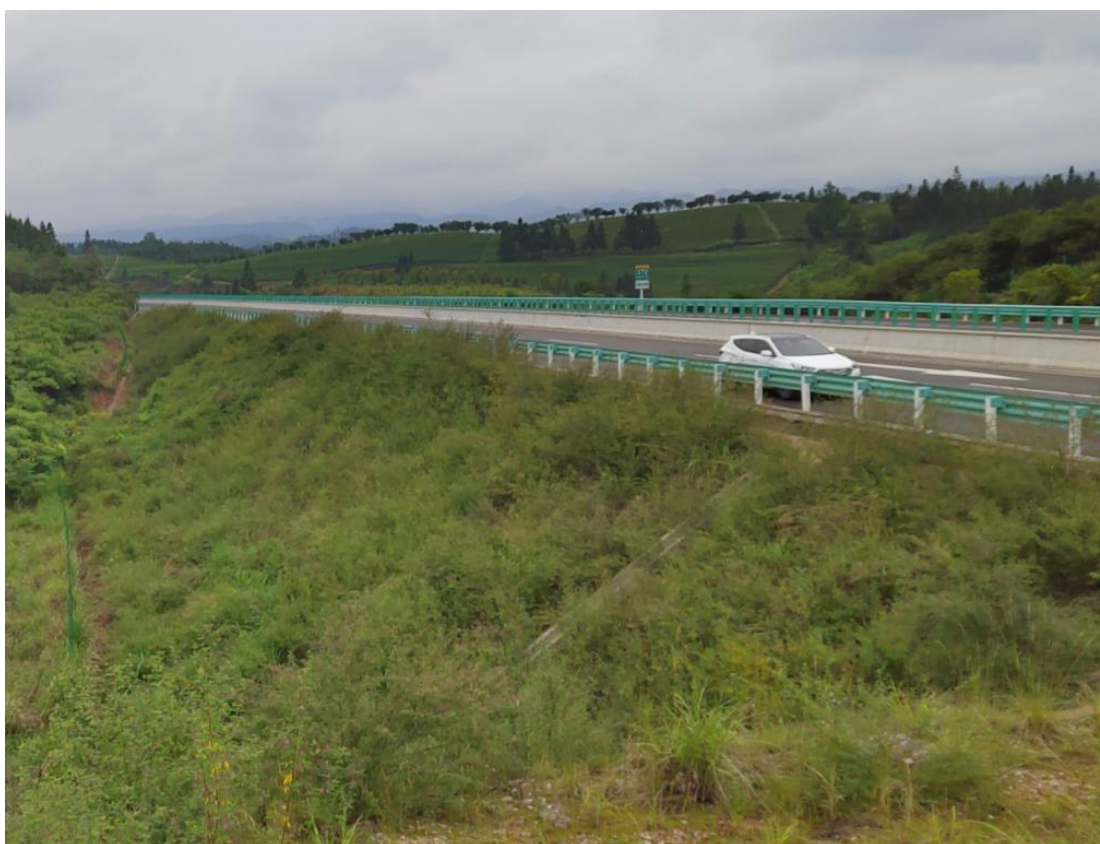
图 2 道路工程区 K7+600 道路左侧排水沟尺寸复核
