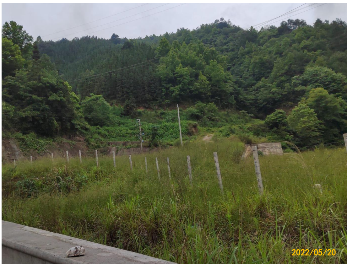
图 12 6#弃渣场复耕及植被恢复情况
