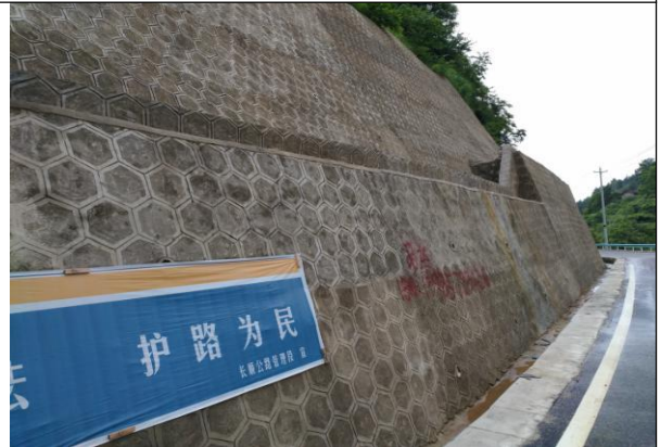
图 10 道路工程区实施德工程措施，属无危害扰动区域
