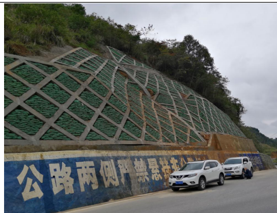
图 14 K17+180 路段边坡修复后情况
