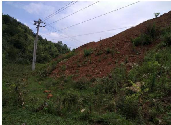
图 11 缓坡土质边坡未治理区域，属扰动加速侵蚀区域
