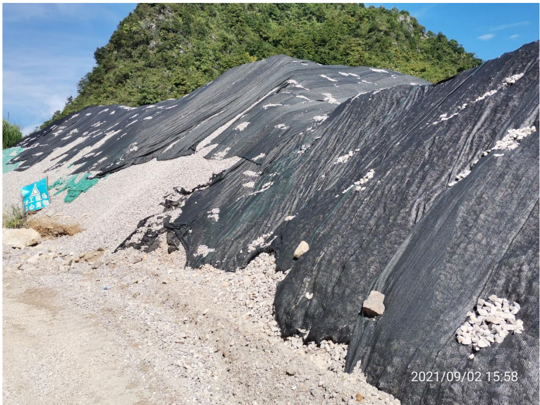
图4 工业场地区临时苫盖
