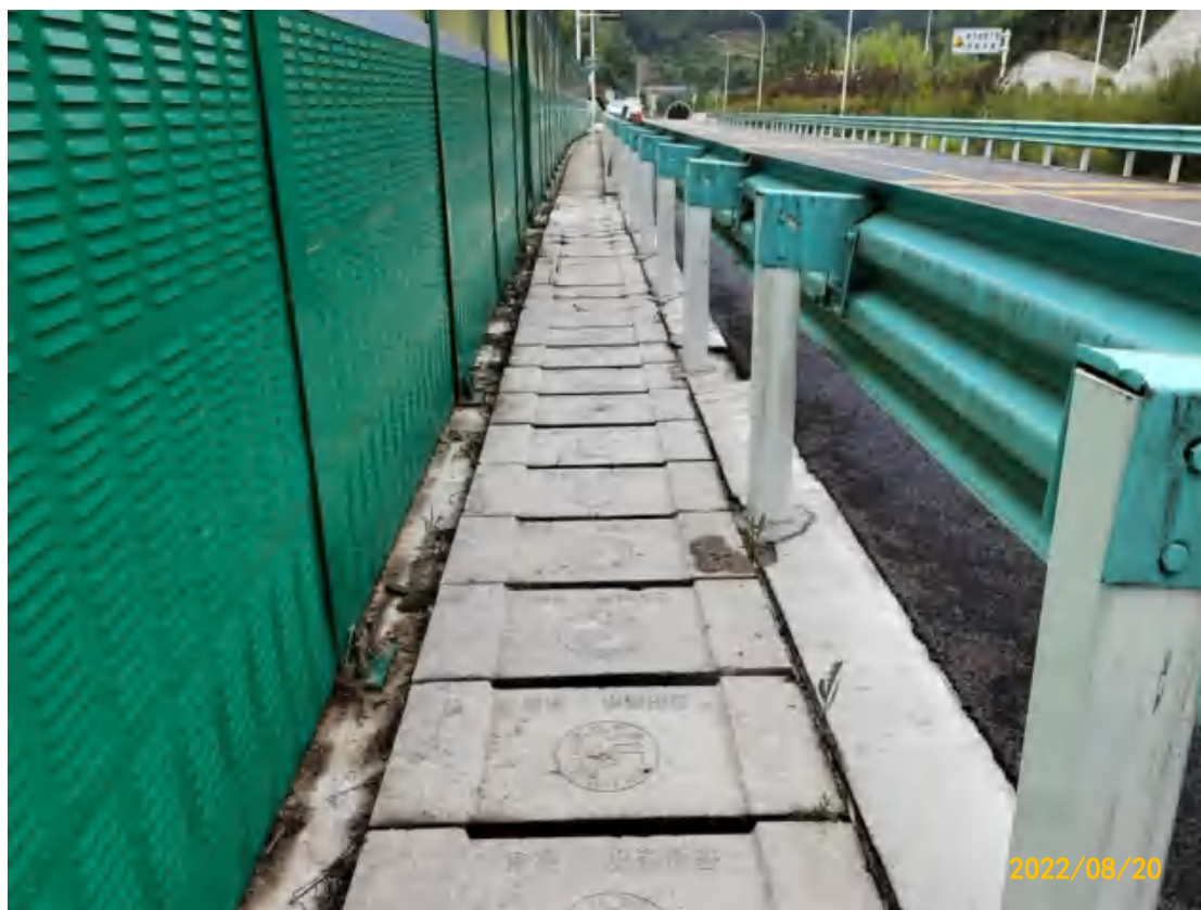
图5 路基工程区 K14+000 道路排水沟
