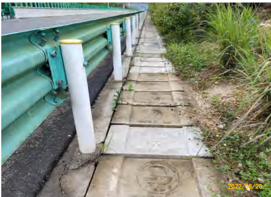
图8 路基工程区 K3+600 道路左侧排水沟
