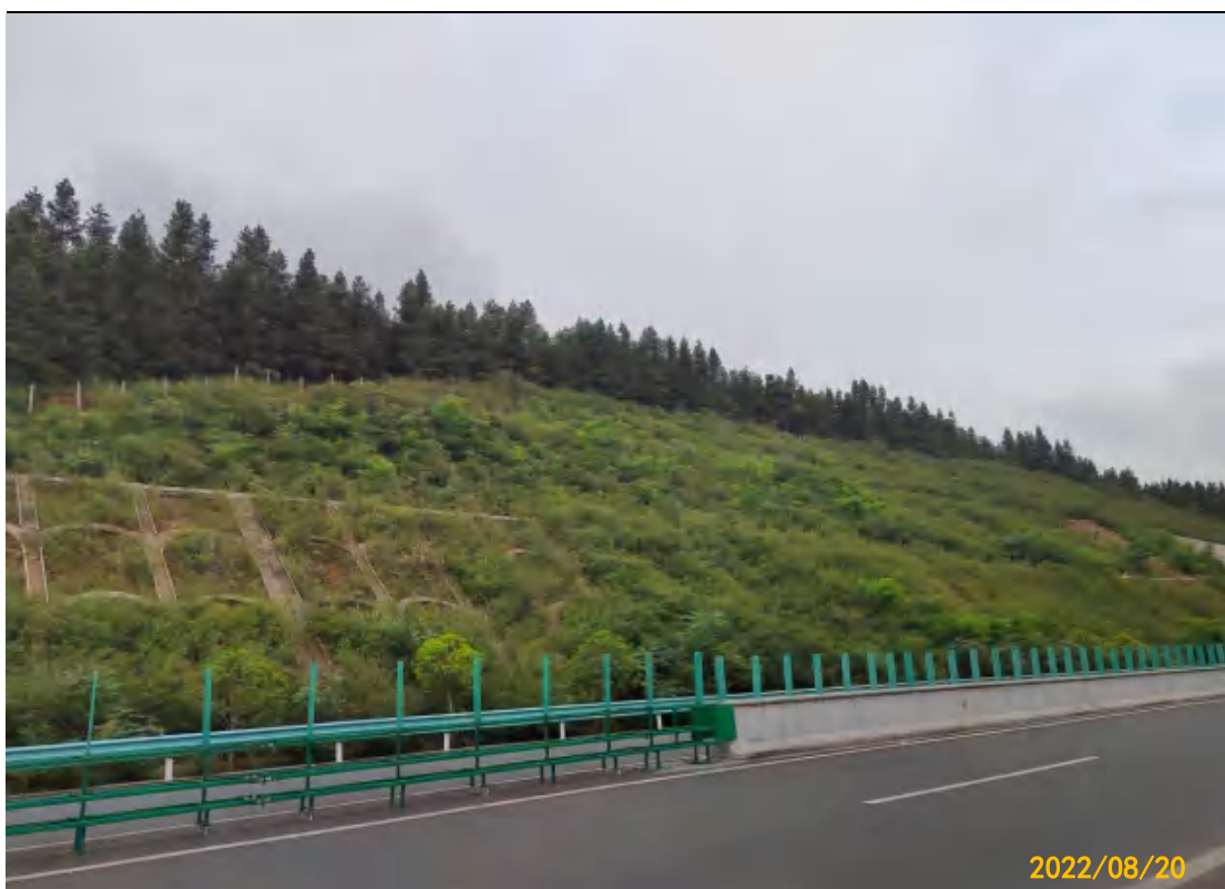
图 10 路基工程区 K4+300 道路边坡综合护坡
