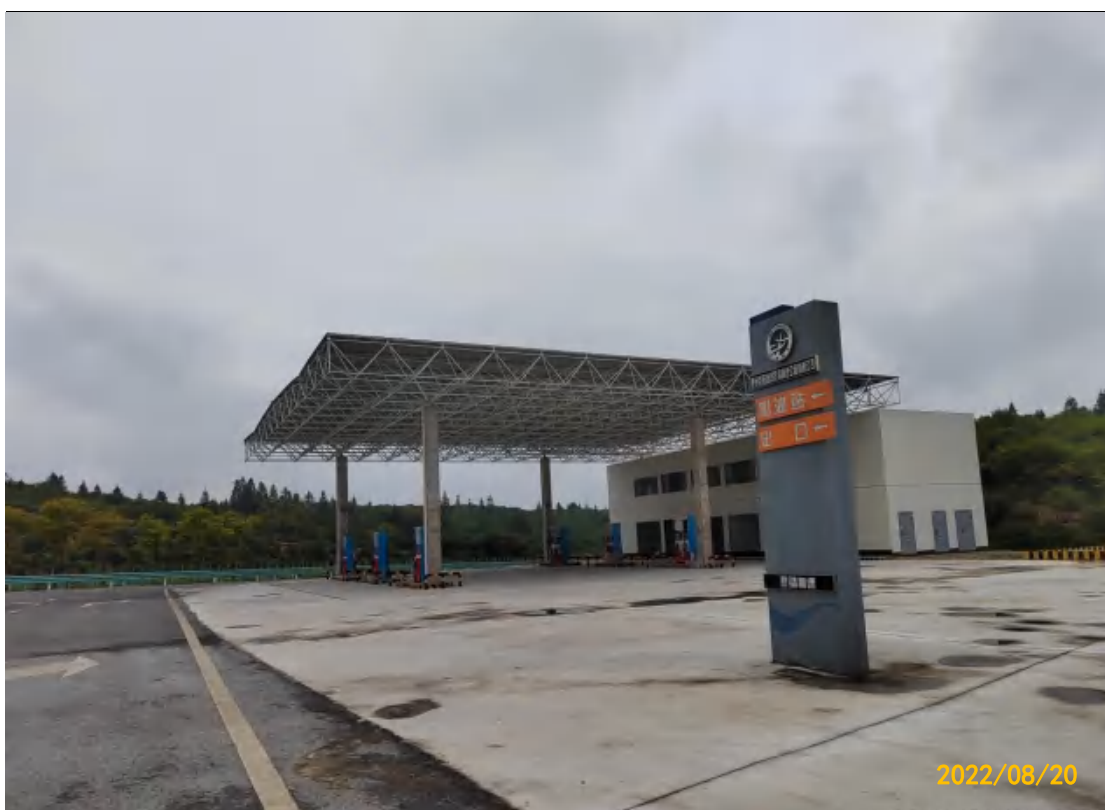
图 12 路基工程区服务区（沿线设施）现状
