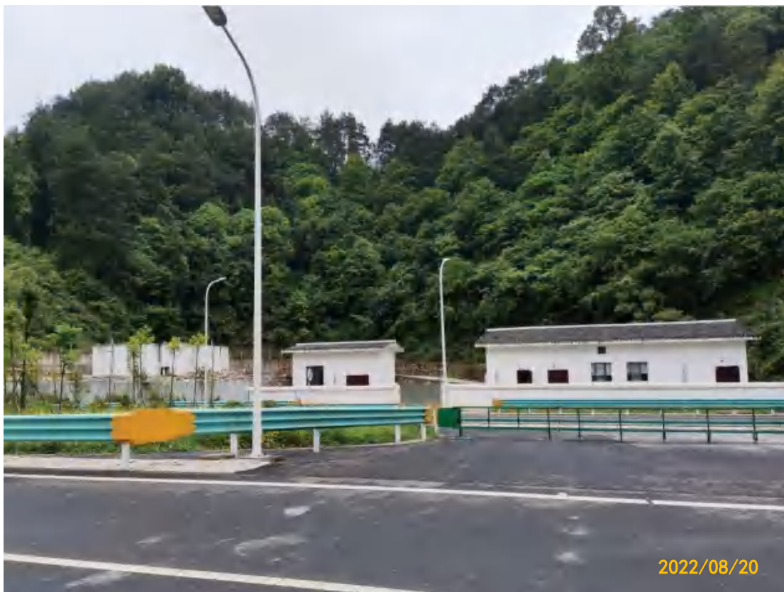
图 11 路基工程区配电设施区域（沿线设施）现状
