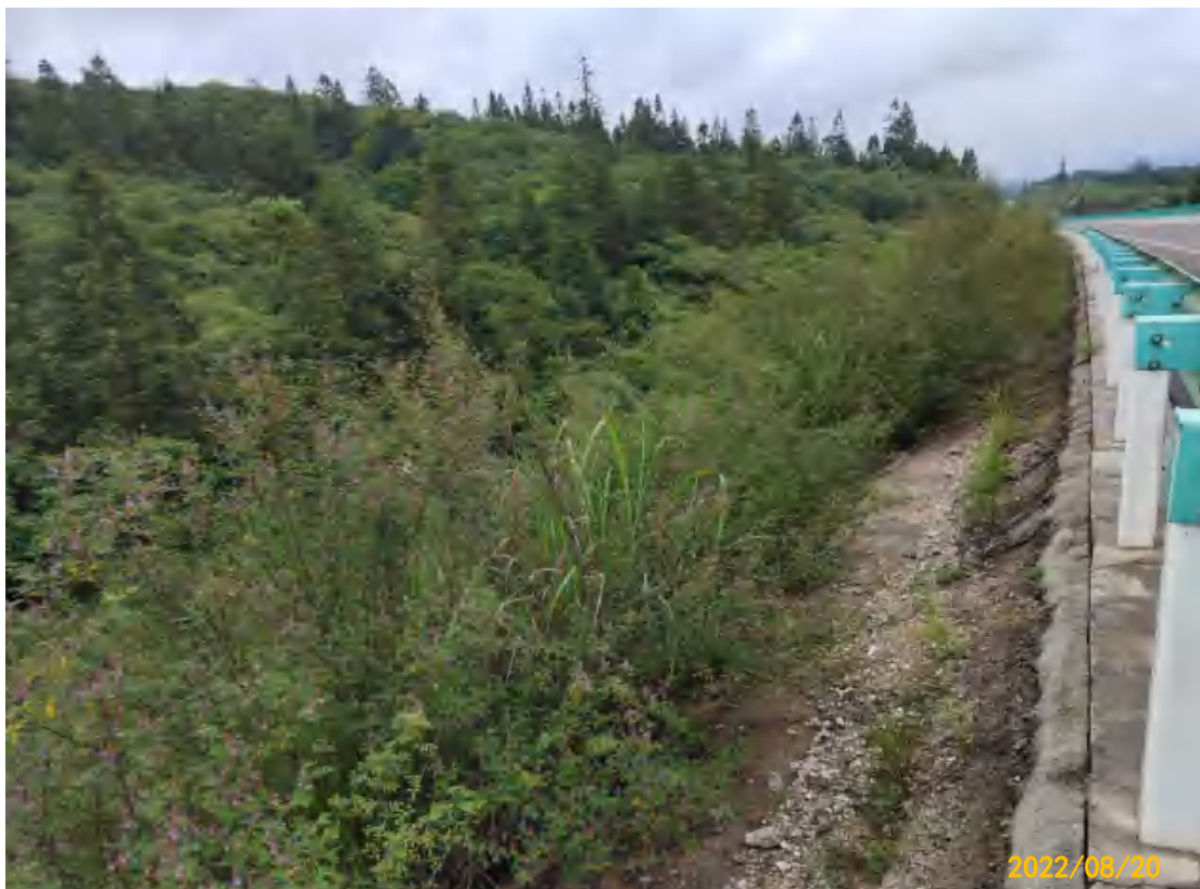
图7 路基工程区 K3+800 道路边坡植被恢复效果
