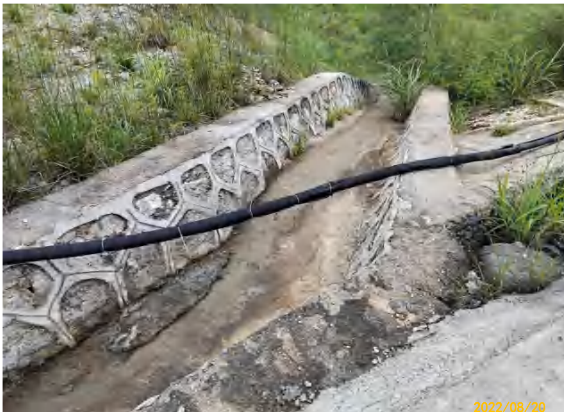
图 9 路基工程区 K3+700 道路左侧排水沟
