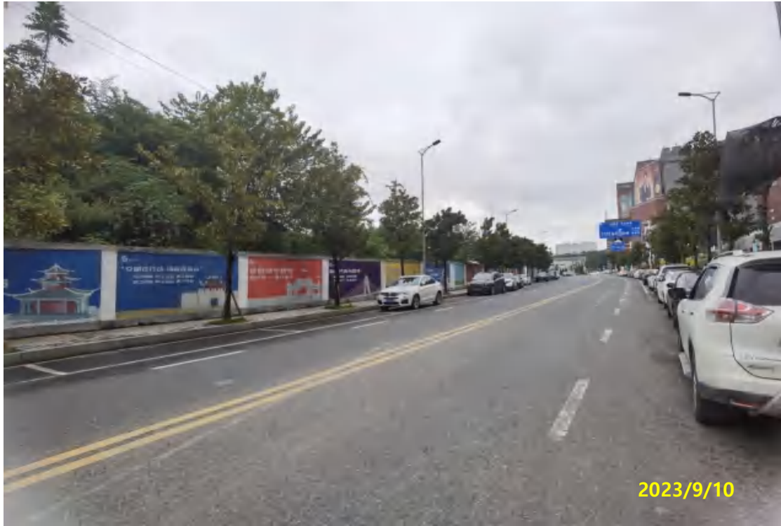
图3 道路路面现状
