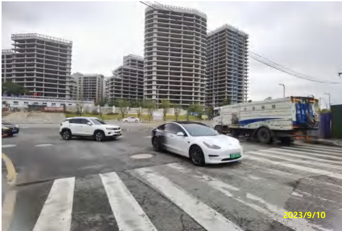
图1 道路起点（与龙水路交叉口）
