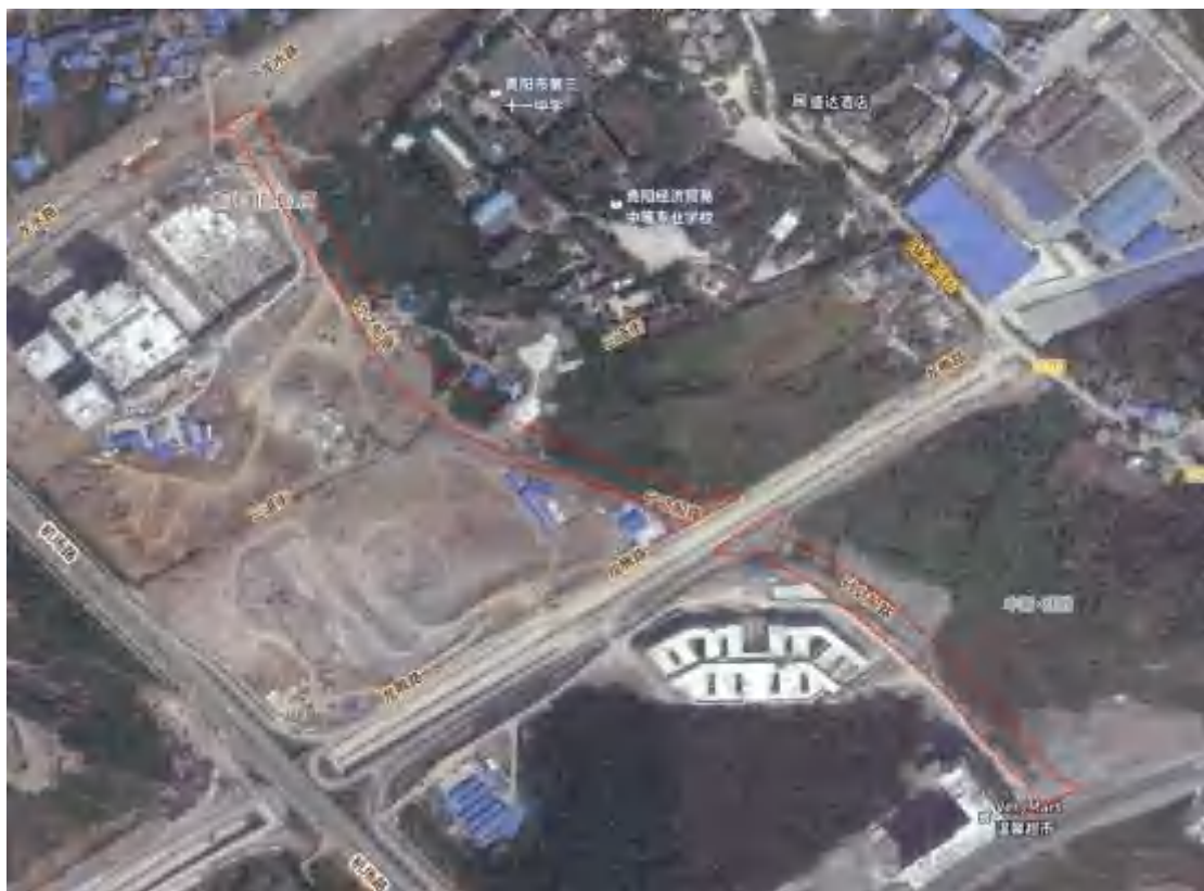
道路工程区建设中卫星影像
