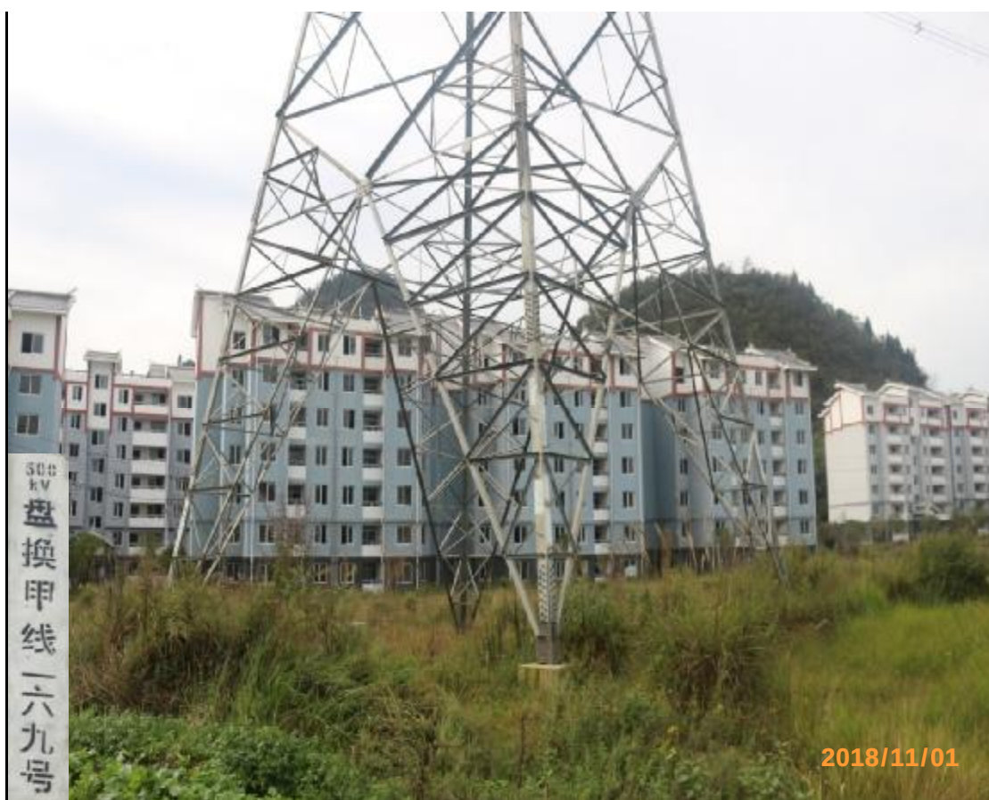
图 18 500kV 盘换甲线 169 号塔基植被恢复情况
