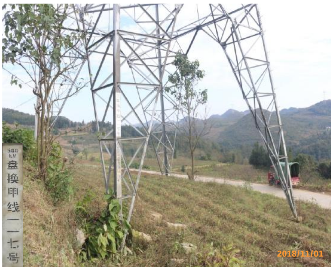
图 6 500kV 盘换甲线 117 号塔基土地复耕情况
