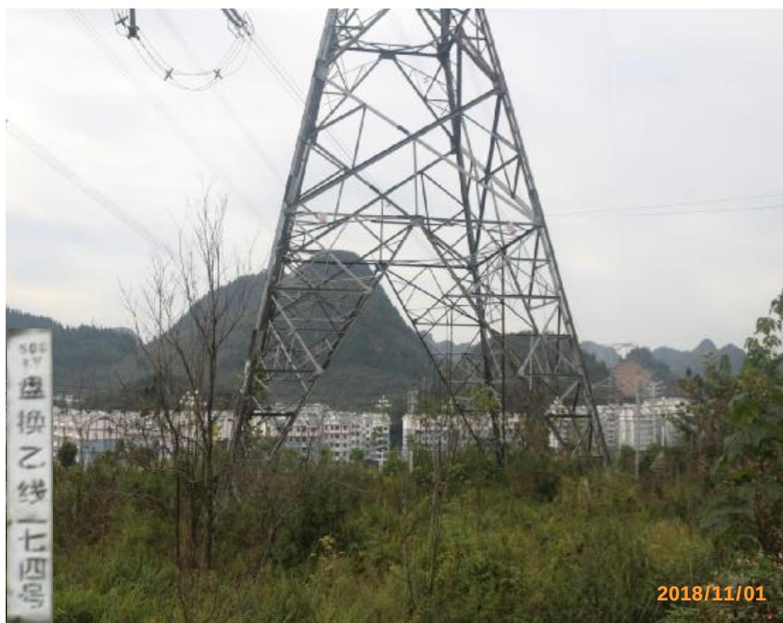
图 22 500kV 盘换乙线 174 号塔基植被恢复情况
