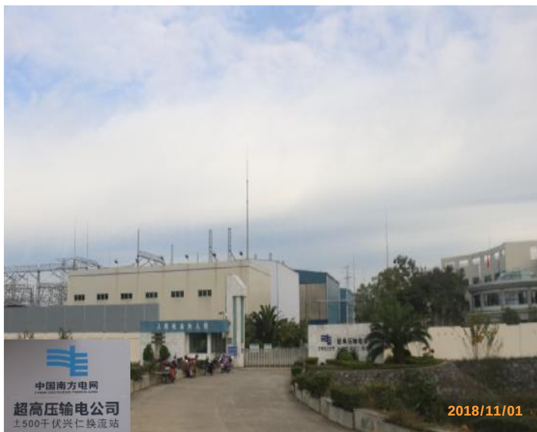
图 24 500 千伏兴仁换流站现状
