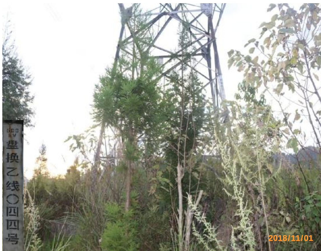
图 3 500kV 盘换乙线 044 号塔基植被恢复情况
