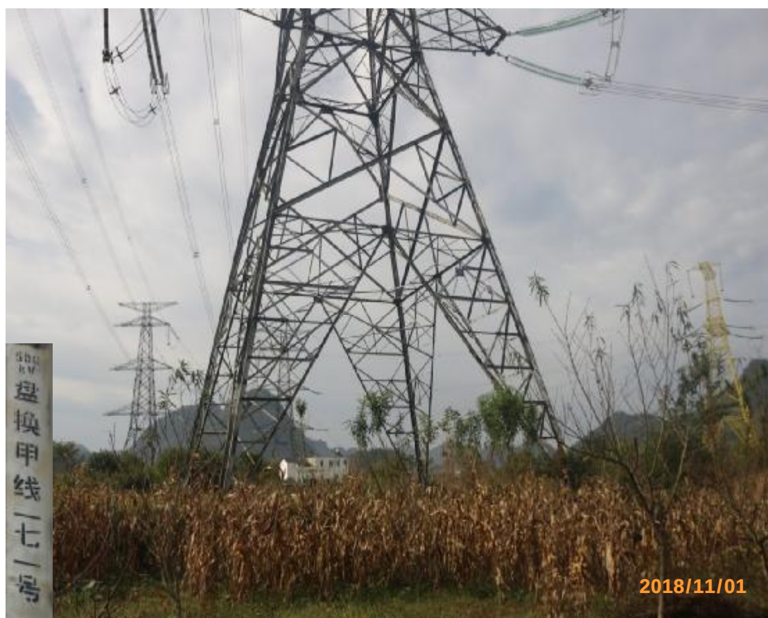
图 20 500kV 盘换甲线 171 号塔基植被恢复情况
