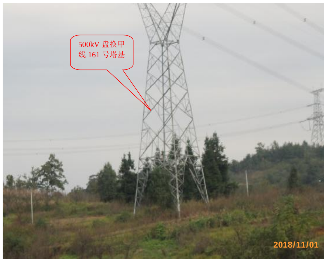
图 15 500kV 盘换甲线 161 号塔基植被恢复情况
