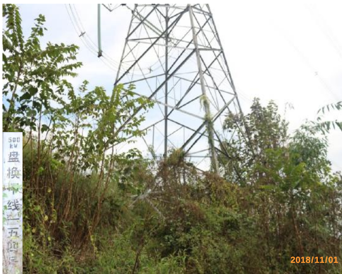
图 12 500kV 盘换甲线 154 号塔基植被恢复情况
