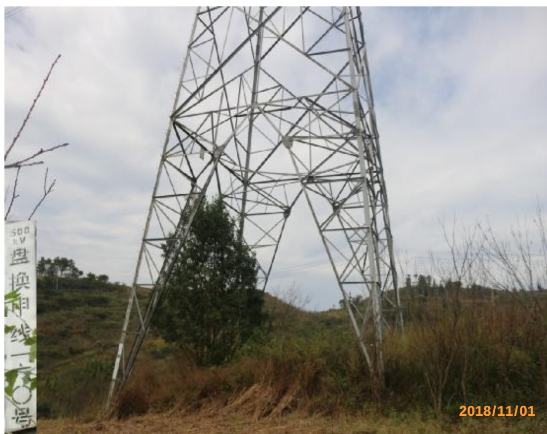
图 14 500kV 盘换甲线 160 号塔基植被恢复情况
