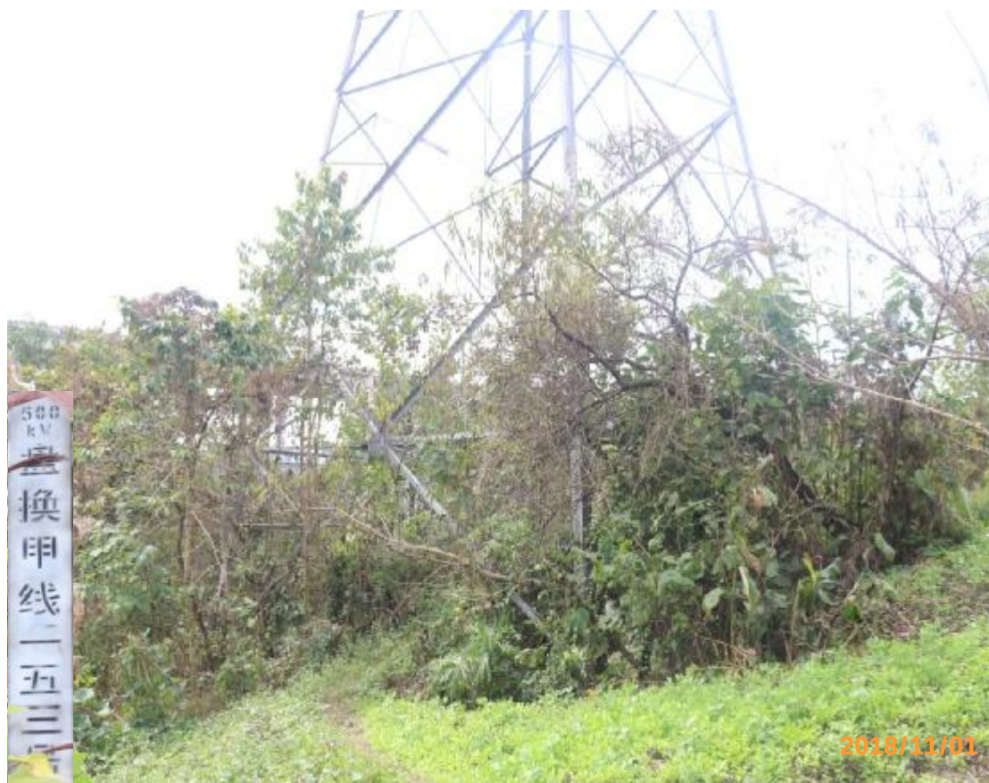
图 11 500kV 盘换甲线 153 号塔基植被恢复情况
