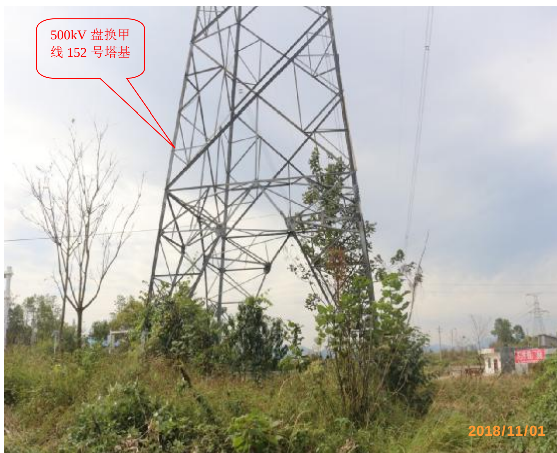
图 8 500kV 盘换甲线 152 号塔基植被恢复情况
