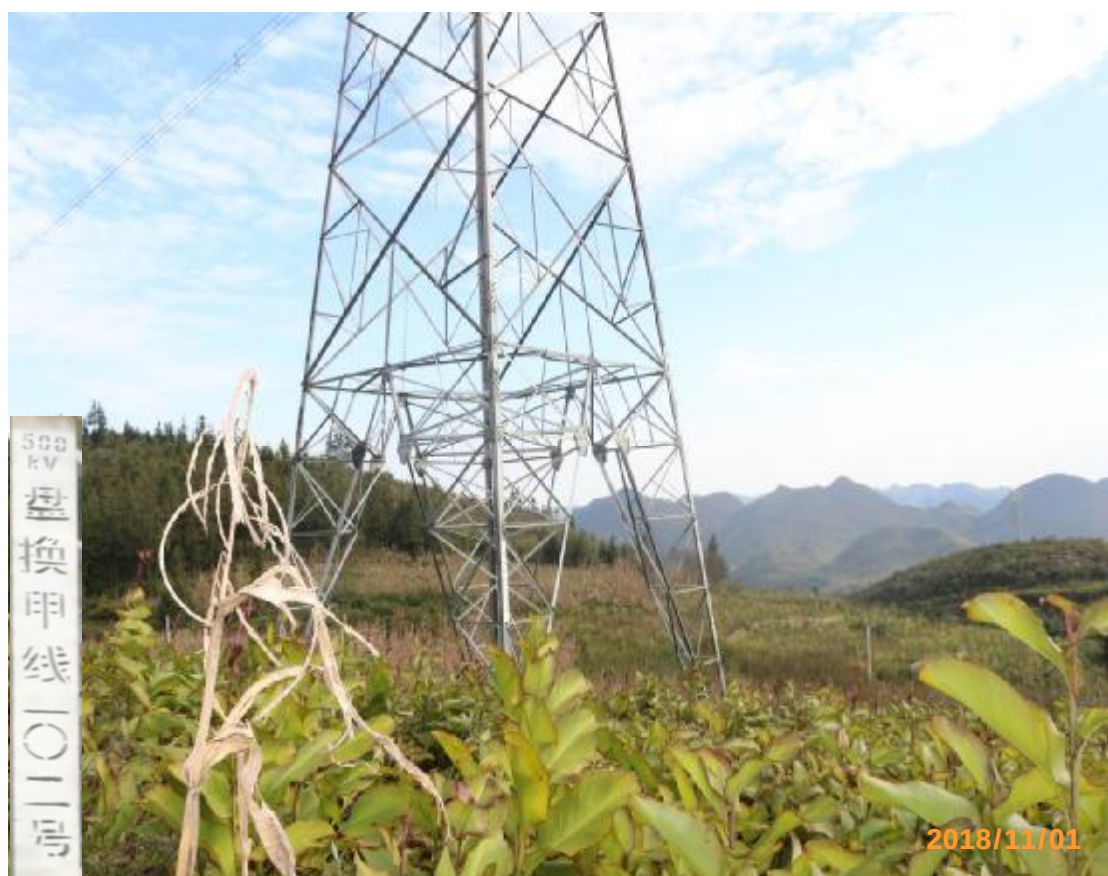
图 4 500kV 盘换甲线 102 号塔基土地复耕情况
