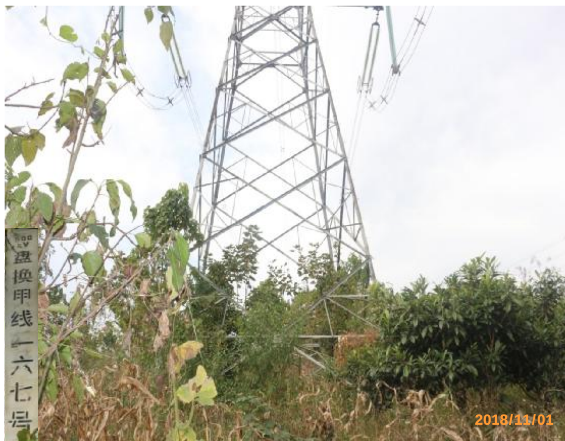
图 17 500kV 盘换甲线 167 号塔基植被恢复情况
