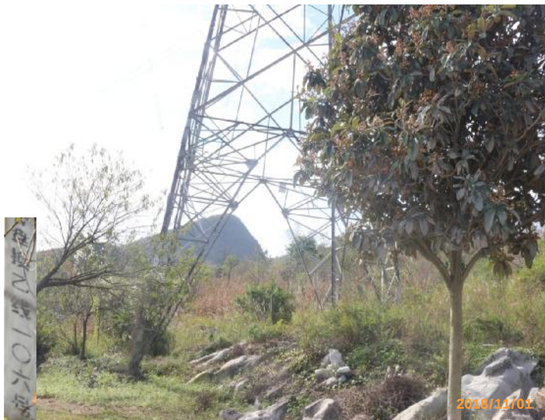
图 5 500kV 盘换乙线 106 号塔基植被恢复情况
