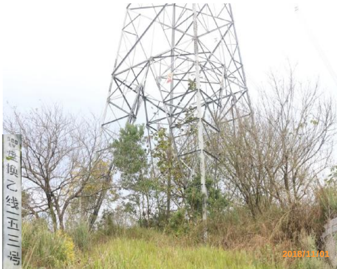
图 10 500kV 盘换乙线 153 号塔基植被恢复情况
