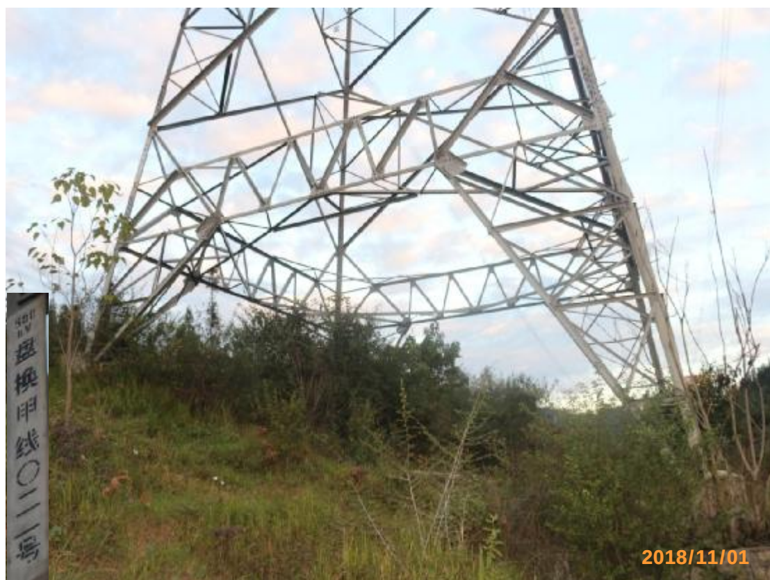
图 1 500kV 盘换甲线 021 号塔基植被恢复情况
