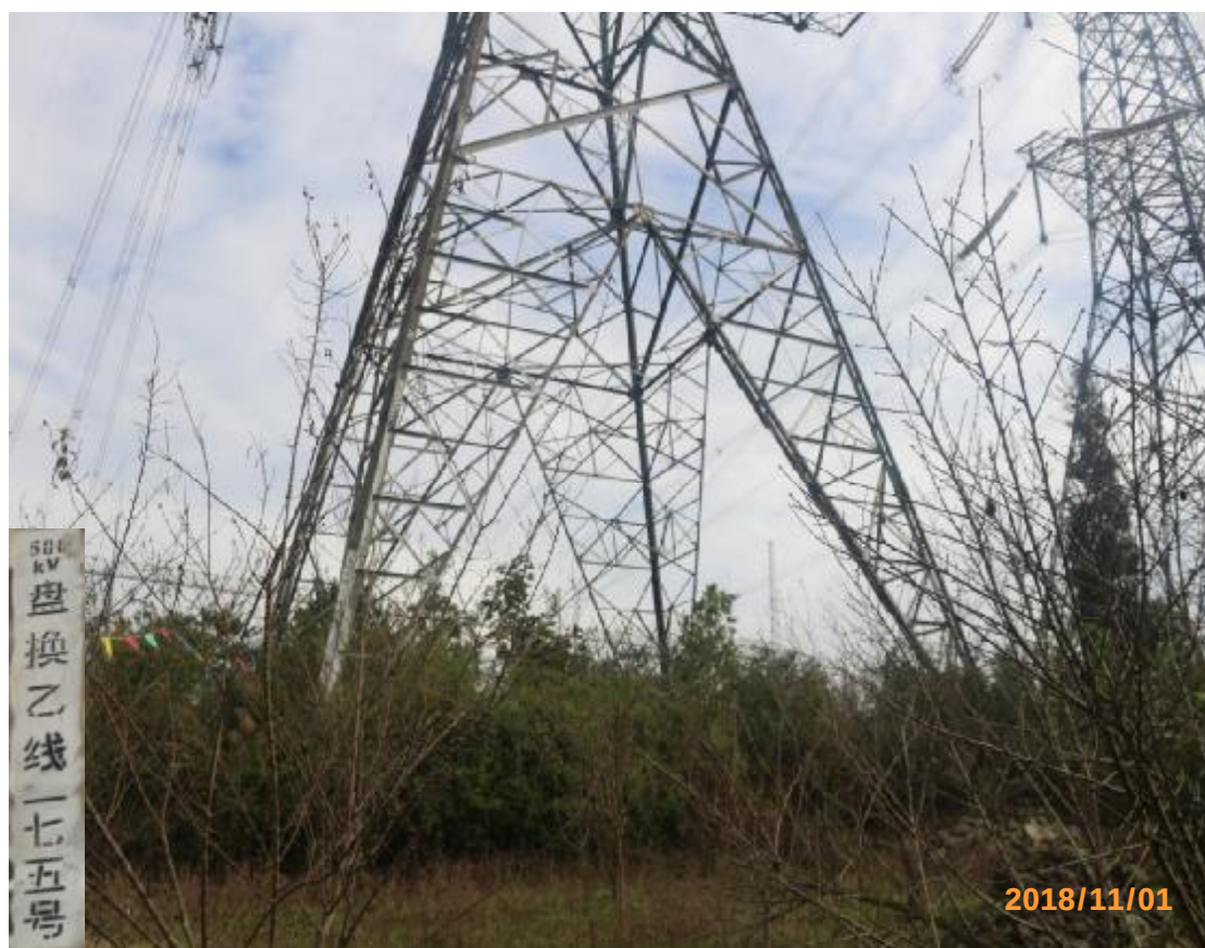
图 23 500kV 盘换乙线 175 号塔基植被恢复情况
