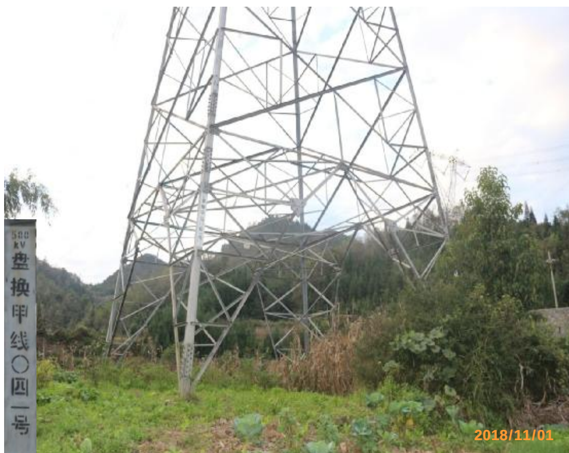
图 2 500kV 盘换甲线 041 号塔基土地复耕情况
