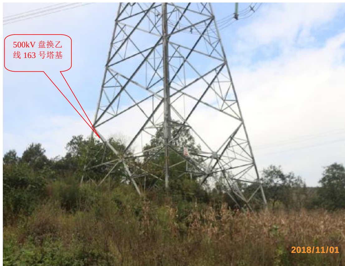
图 16 500kV 盘换乙线 163 号塔基土地复耕情况
