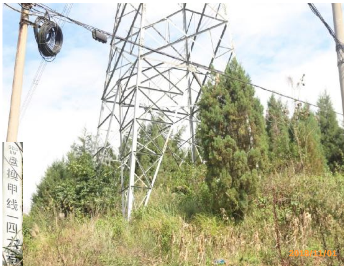
图 7 500kV 盘换甲线 146 号塔基植被恢复情况
