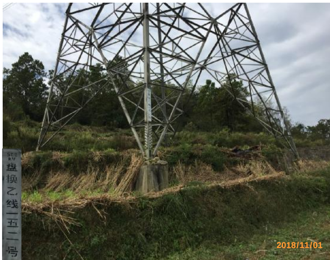
图 9 500kV 盘换乙线 152 号塔基土地复耕情况
