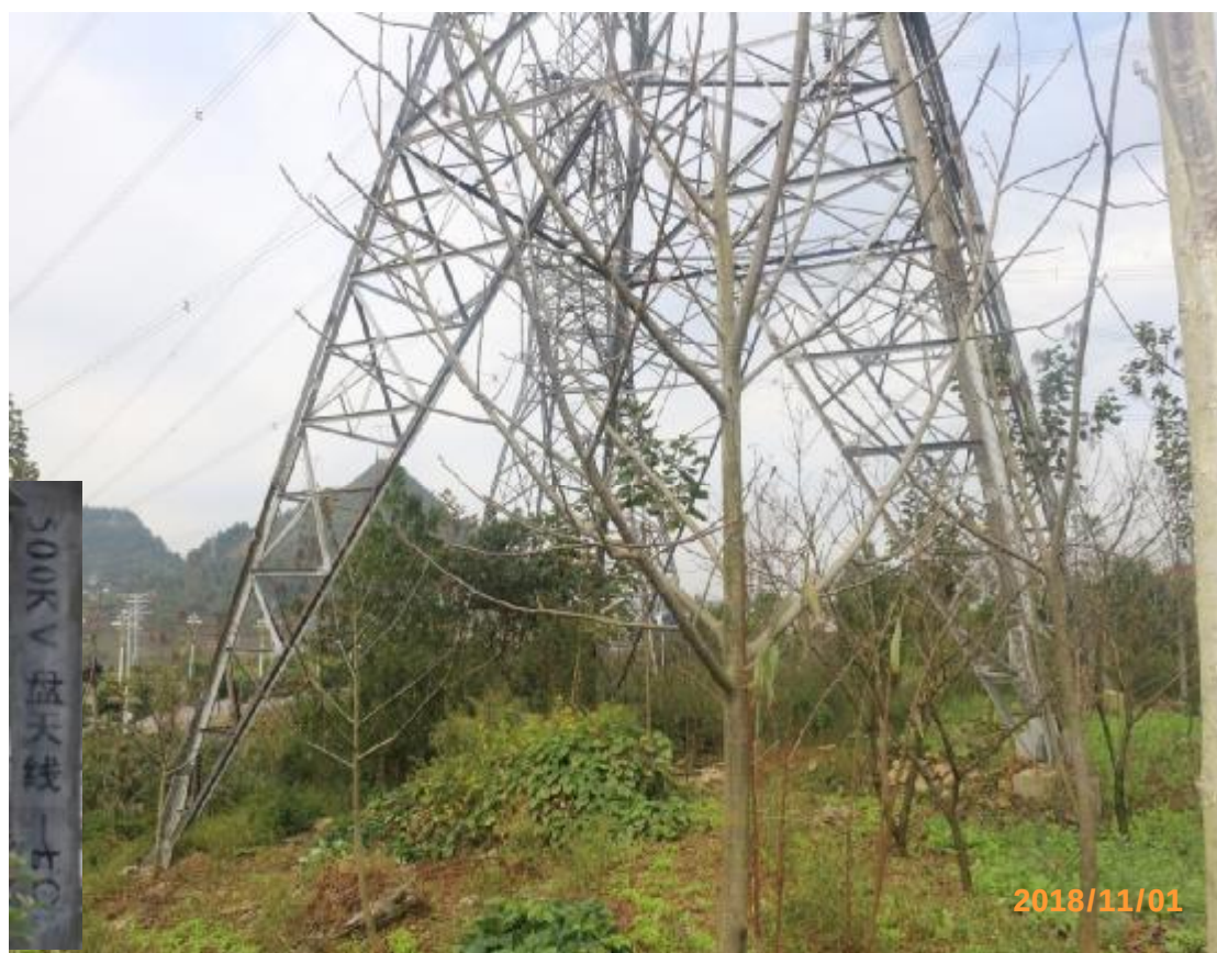
图 19 500kV 盘换甲线 170 号塔基土地复耕情况
