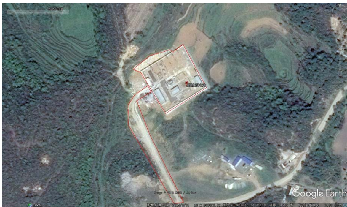
附图 4 鹏城变电站建设前后遥感图
