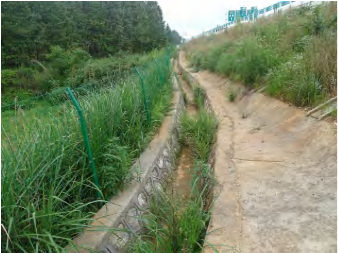
图8 建设区工程措施实施效果
