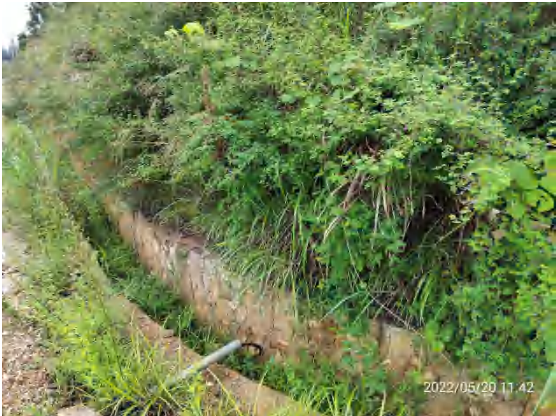
图 5 建设区工程措施实施效果
