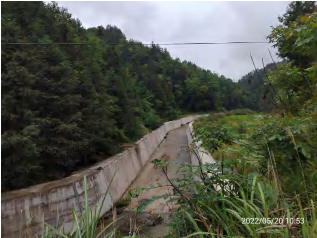
图2 建设区工程措施实施效果
