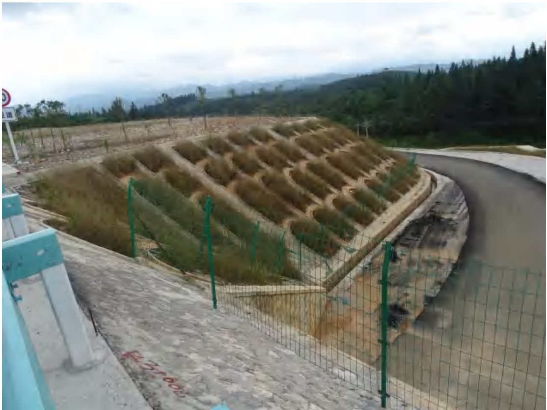
图9 建设区工程措施实施效果
