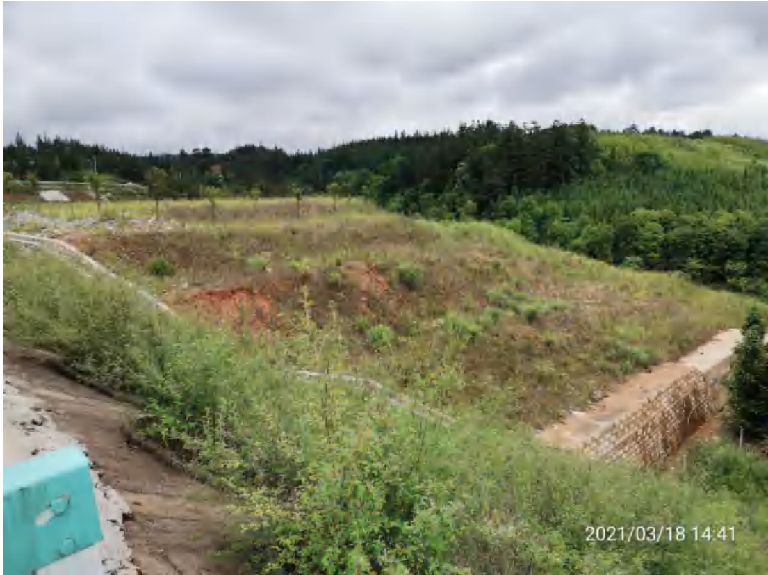
图 6 建设区工程措施实施效果
