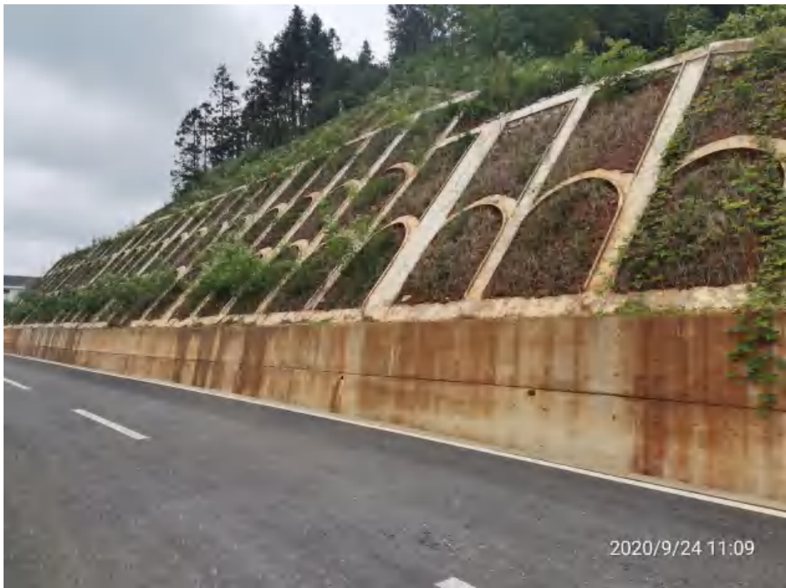
图 7 建设区工程措施实施效果
