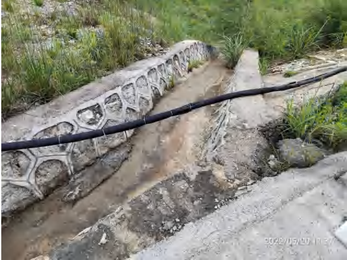
图 4 建设区工程措施实施效果
