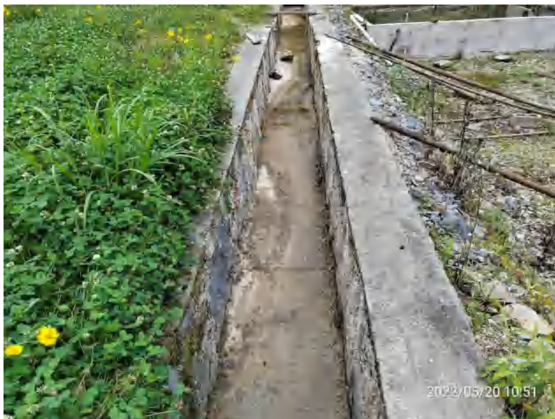
图1 建设区工程措施实施效果
