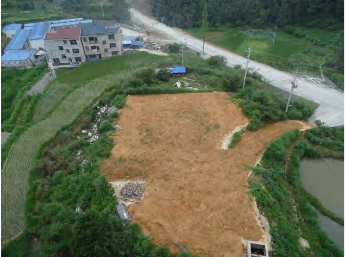
图 18 临时施工营地治理航拍效果
