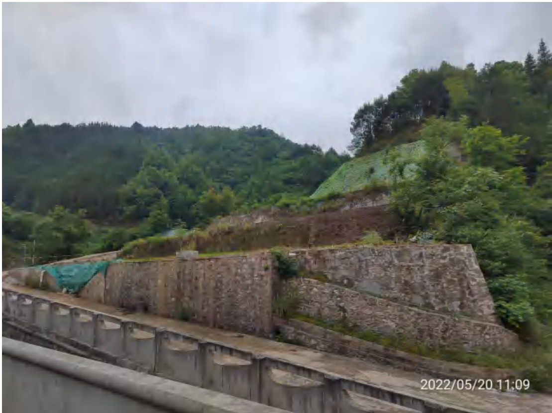
图3 建设区工程措施实施效果
