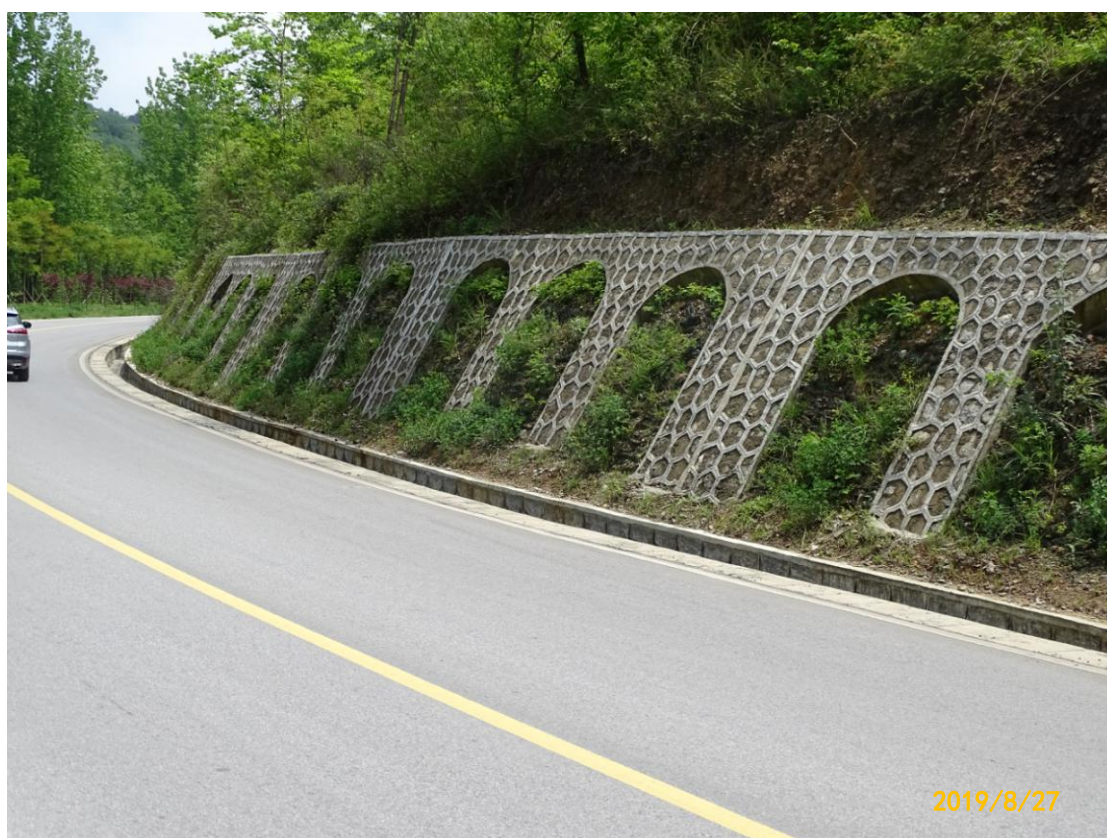
图 16 道路工程区 K16+400 道路左侧边坡治理效果
