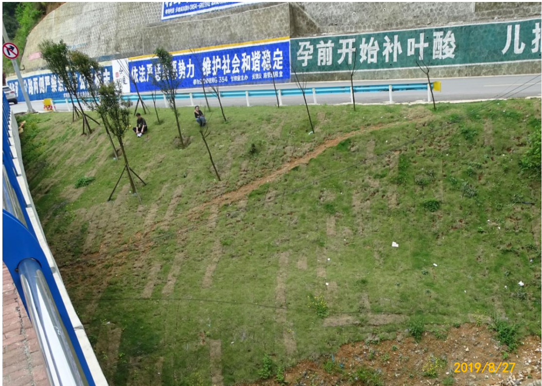
图 17 道路工程区克炳中桥边坡治理效果
