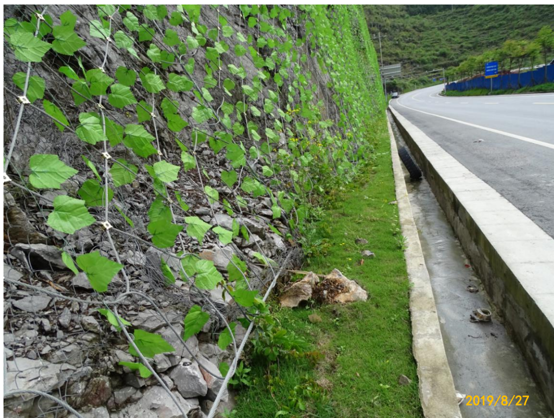
图5 道路工程区 K5+600 道路右侧实施的藤蔓植物及草皮恢复情况
