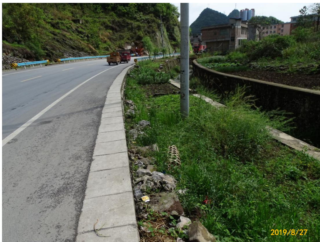
图 2 道路工程区 K3+900 道路左侧植被恢复效果
