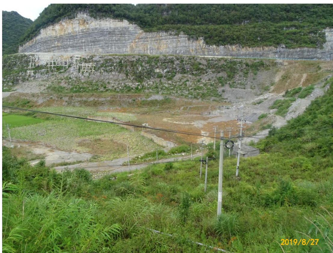
图6 施工生产场地土地整治及复耕情况
