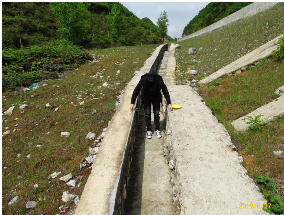
图 9 道路工程区 K7+600 道路左侧排水沟尺寸复核
