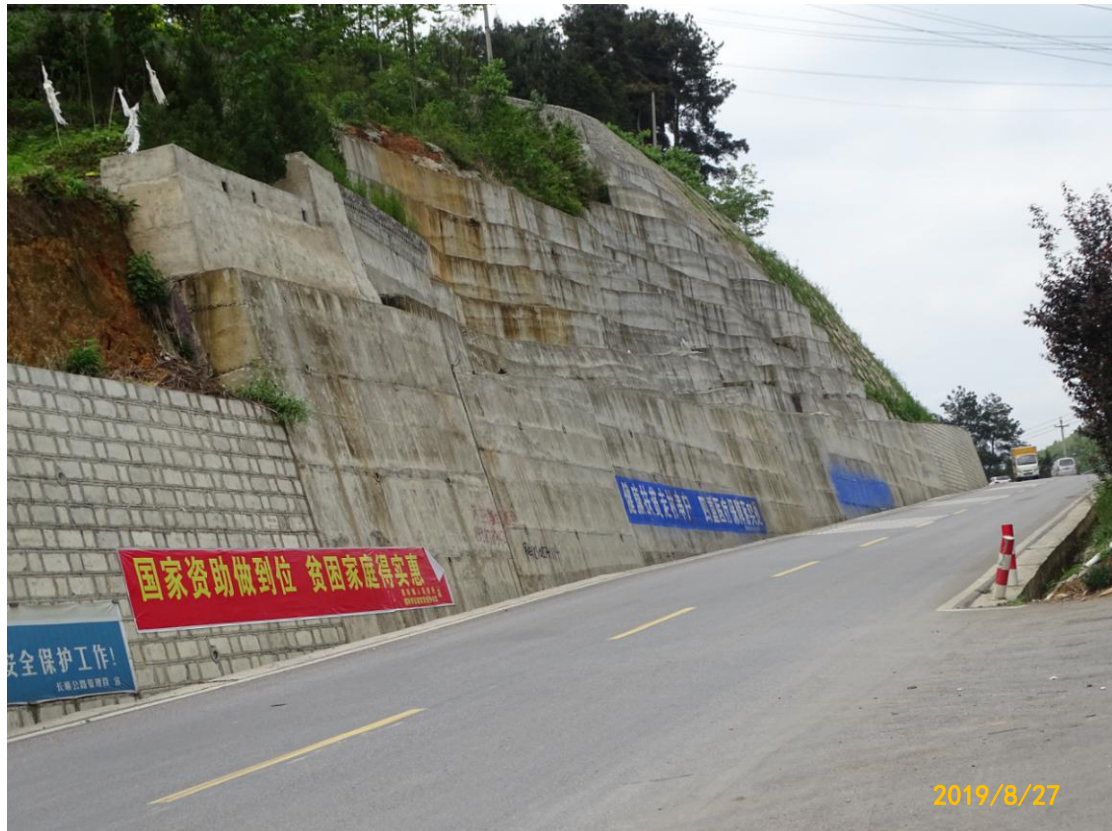
图 21 道路工程区 K21+350 道路右侧挡土墙防治效果
