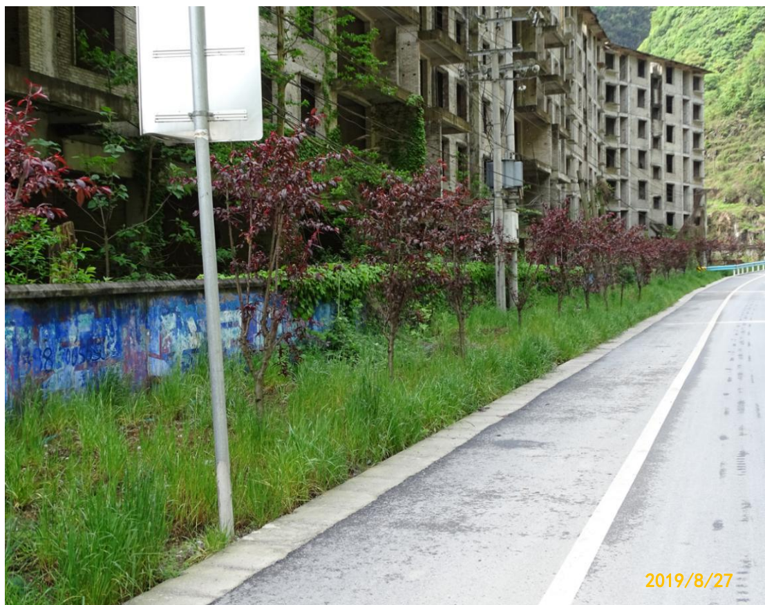
图3 道路工程区 K4+100 道路左侧植被恢复效果
