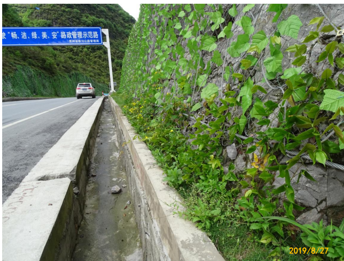
图4 道路工程区 K4+900 道路右侧实施的排水沟及藤蔓植物
