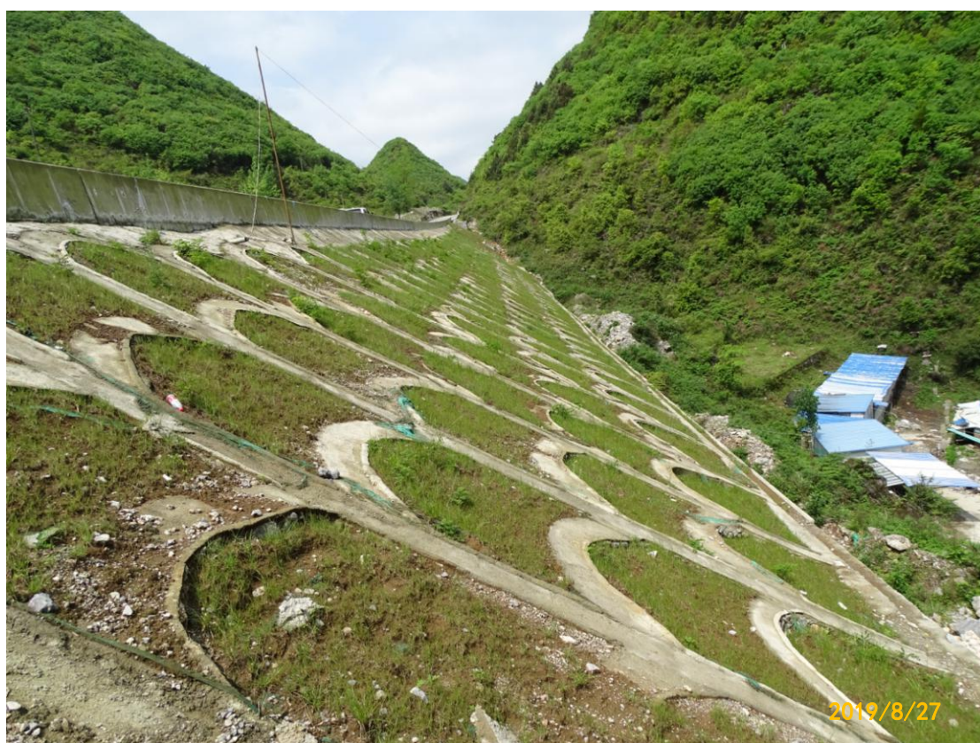
图 8 道路工程区 K7+600 道路右侧综合护坡实施效果
